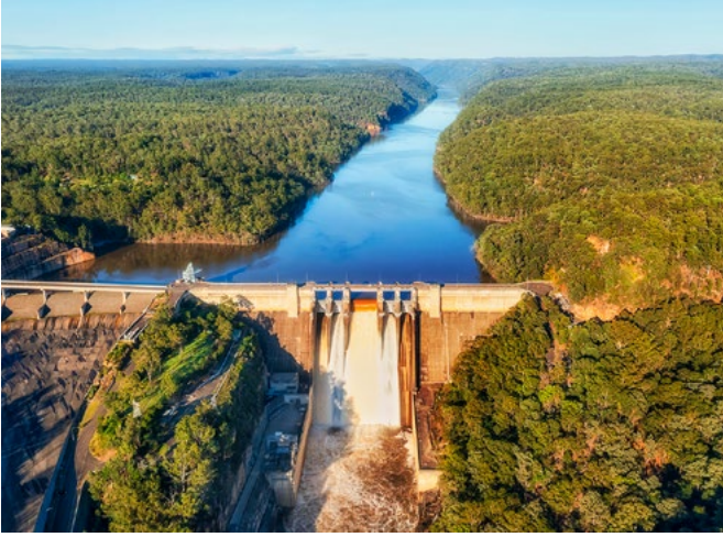
Warragamba Barajı. Fotoğraf: iStock, zetter, 2022.
