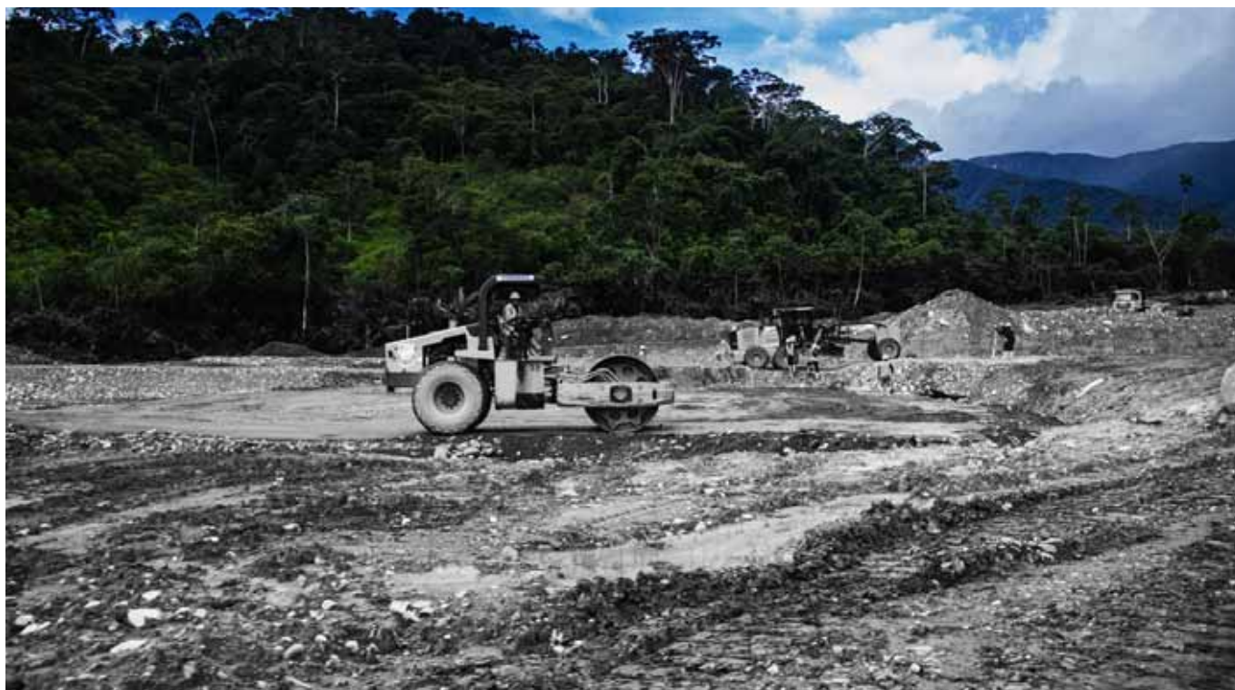
Construyendo el campamento de la futura mina a cielo abierto Mirador en Tundayme, Zamora-Chinchipec, Ecuador. Foto por Omar Ordóñez.
