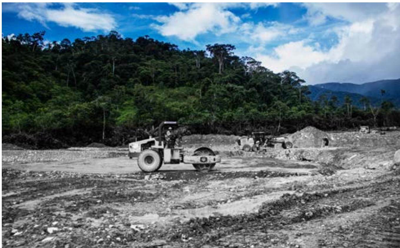
Постройка лагеря для будущего медного карьера «Mirador» в местности Тундайме, область Замора-Чинчипе, Эквадор. Фото Омара Ордоньеса.
