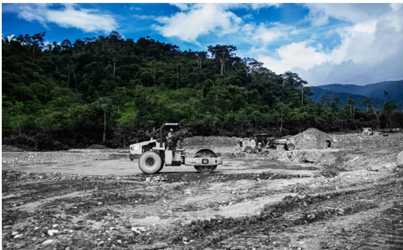
Pe terenul de construire al viitoarei mine de exploatare la suprafață numită Mirador, în Tundayme, Zamora-Chinchipe, Ecuador. Fotografie de Omar Ordoñez.
