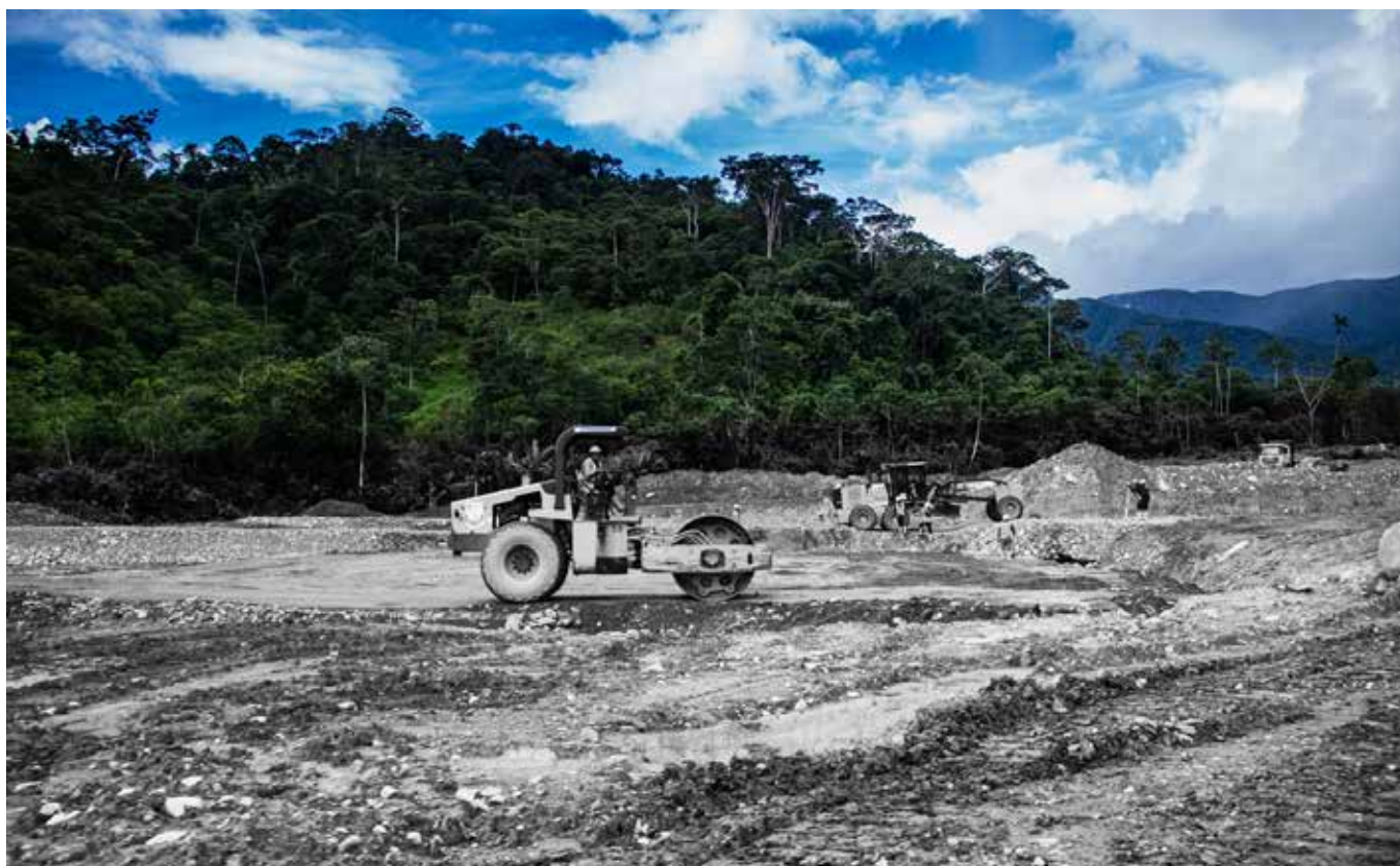
Budowa odkrywkowej kopalni miedzi Miradorw Tundayme, Zamora-Chinchi w Ekwadorze. Zdjęcie: Omar Ordoñez.
