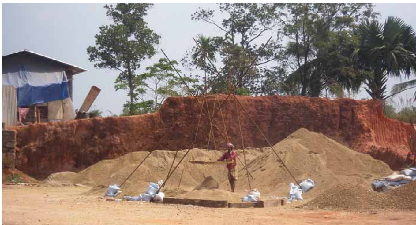
Travaux de construction réalisés par Uralungal, la plus ancienne coopérative de production d'Inde.
