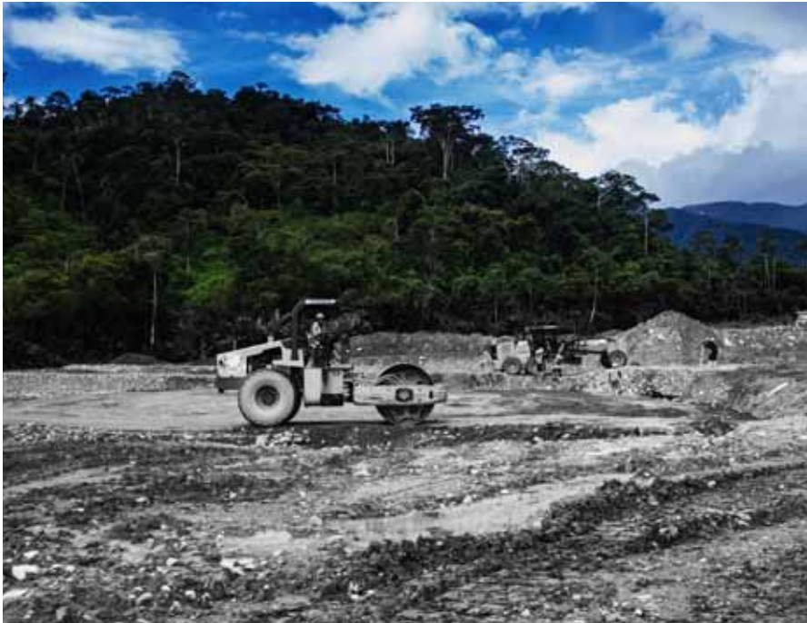
Les travaux en vue de la future mine de cuivre à ciel ouvert Mirador sont en marche, à Tundayme, dans la région de Zamora-Chinchipec en Équateur. Photo de Omar Ordoñez.
