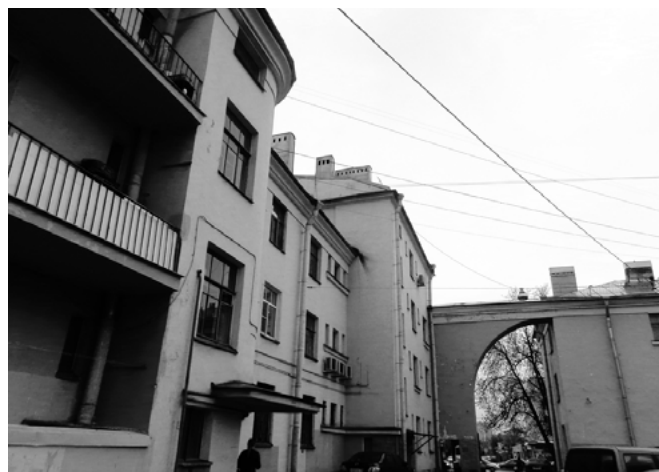
Fotografia 2: Clădiri de pe strada Tractornaya.
