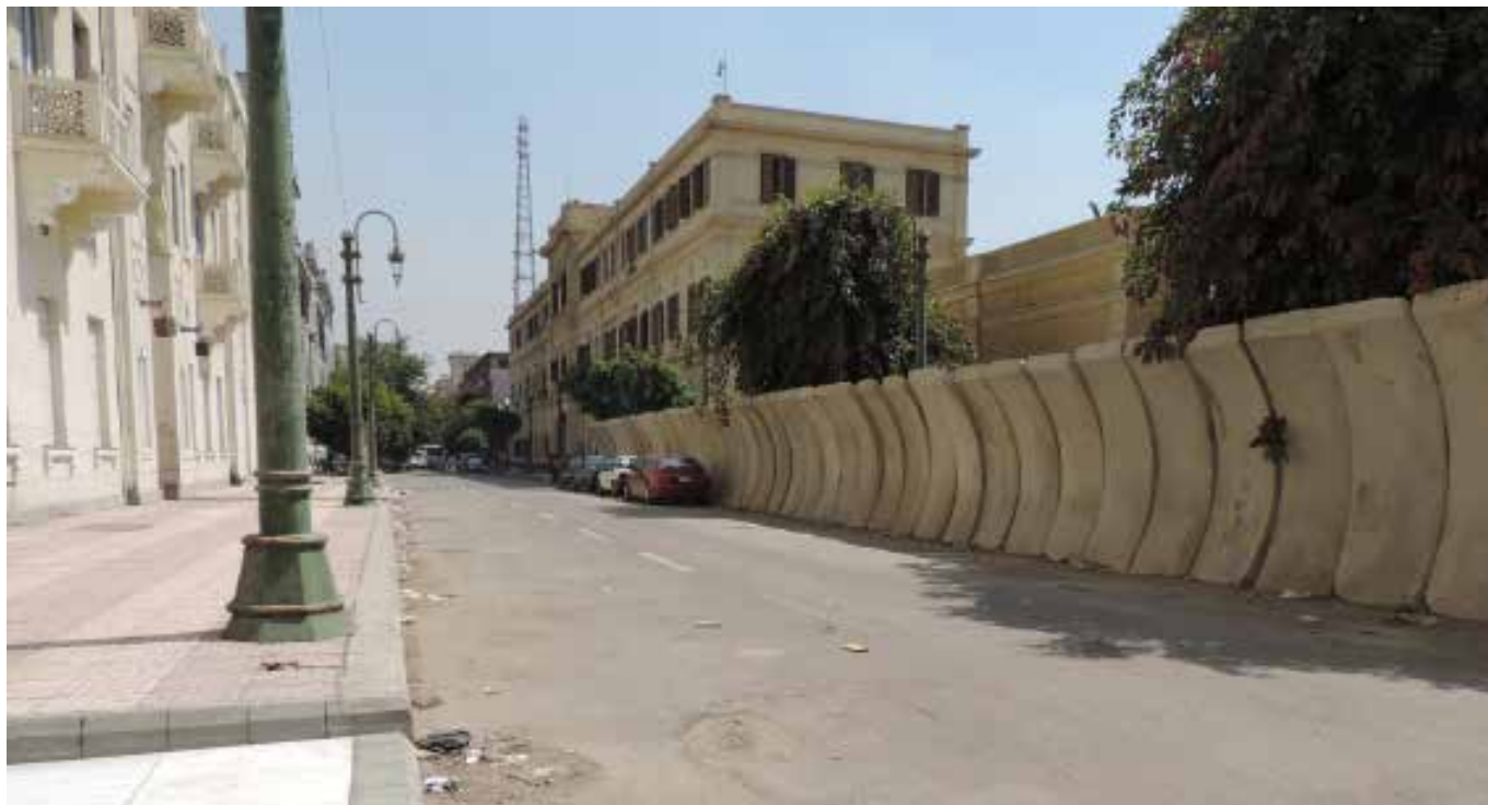
Nowowytbudowany wklęsty mur, wzniesiony naprzeciw głównego wejścia do Amerykańskiego Uniwersytetu w Kairze. Zdjęcie: Mona Abaza, 21 września 2015.
